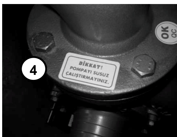
[4] Pe pompă: „Nu porniți și nu utilizați fără apă”.
